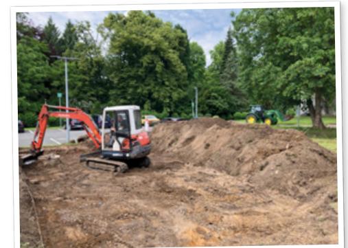
Bagern für den neuen Schuppen hinterm Gemeindehaus
