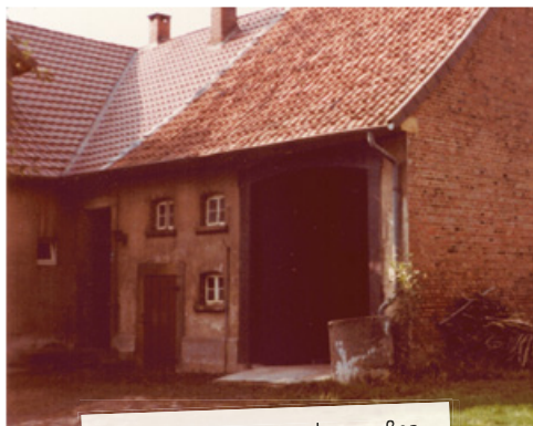
Die Pfarrscheune vor dem großen Um- und Anbau 1984 ...
